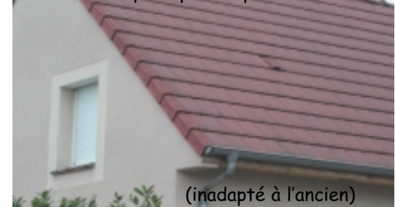
Volumes et matériaux propres aux bâtiments agricoles
