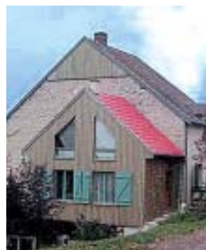
Percements en pignon
